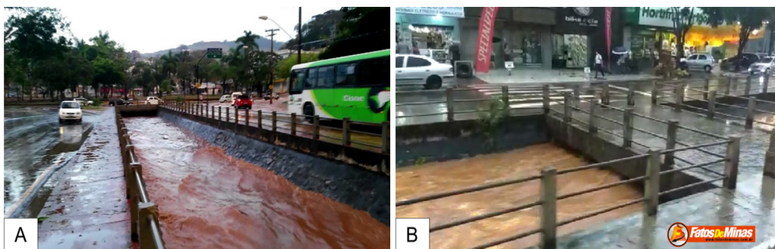
Figura 3 – (A) Detalhe do canal ao longo da Av. Carlos Drummond de Andrade, (B) Detalhe do Canal ao longo da Av. Carlos de Paula Andrade, fevereiro 2018.
